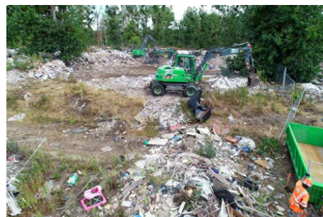
Tri par pelle mécanique
