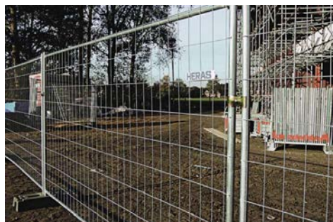
Clôture grillagée provisoire
